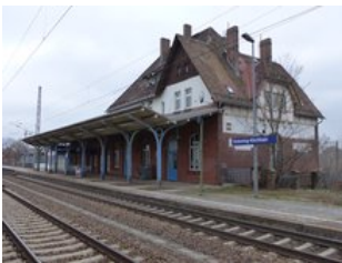
Ansicht von der oberen Bahnsteigseite
