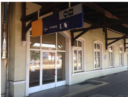
Der Zugang in das Empfangsgebäude am Hausbahnsteig
