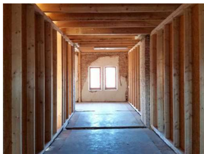
Das Dachgeschoss wurde vor Kurzem saniert und für eine Nutzung vorbereitet.
