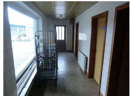
Flur im südöstlichen Toilettenanbau; links: Blick auf die Gleisanlagen
