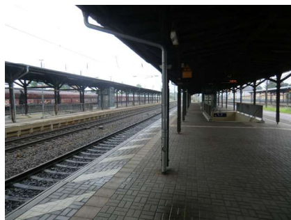
Blick nach Osten über den Hausbahnsteig mit der Unterführung
