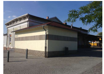
Beim Toilettentrakt an der Südostseite handelt es sich um einen späteren Anbau.
