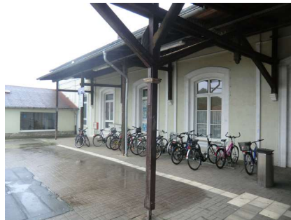
Die Bike+Ride-Anlage am Empfangsgebäude hat funktionale Mängel.
