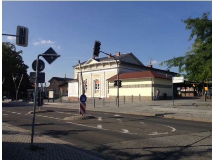
Blick vom ZOB auf das Empfangsgebäude
