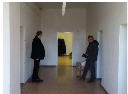
Auch der Flur im Obergeschoss zeigt, dass der bauliche Zustand an sich gut ist.
