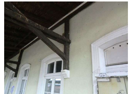
Das Bahnsteigdach schließt direkt an die Fassade des Empfangsgebäudes an.
