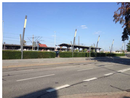
Blick vom ZOB auf die Bahnanlagen und die Park+Ride-Anlage
