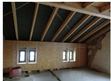
Im Rohbau ausgebauter Raum im Dachgeschoss
