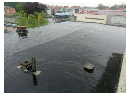
Das Dach des eingeschossigen Anbaus wurde erst vor Kurzem saniert.
