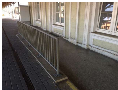
Der mittels einer Rampe barrierefrei gestaltete Gebäudezugang
