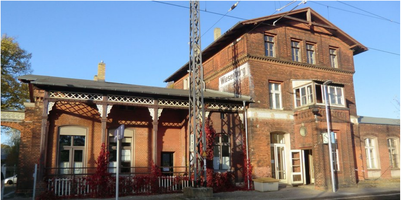
Bahnhofsansicht von der Bahnsteigseite
