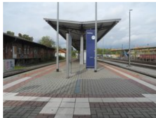
Bahnsteig mit saniertem Dach
