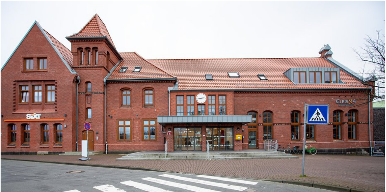
Vorplatzansicht Empfangsgebäude (Foto: Martin Limper, Bürgerbahnhof Cuxhaven e.G)
